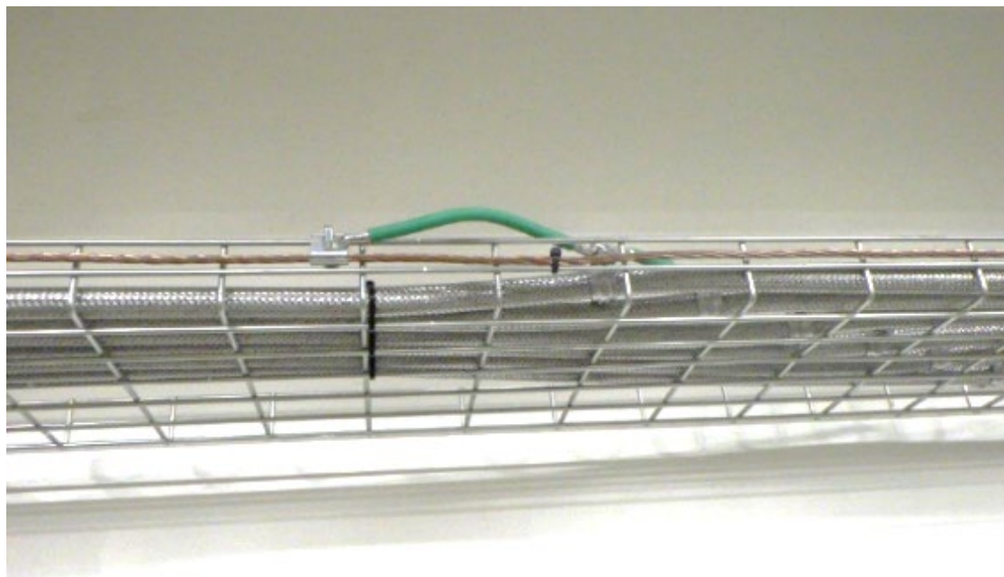
Figure 2 – Exemple de réalisation d'une mise à la terre des flexibles hélium.
